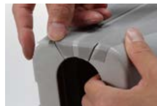
7. 表面用テープ（グレー色）の 端部を折り返し
